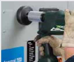
Perforación de orificio
