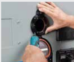
Colocación y sujeción de la compuerta
