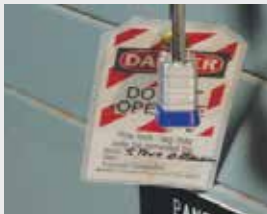
Desconexión eléctrica y señalización
